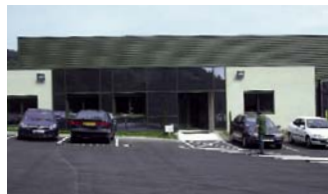
Nouveau laboratoire et nouveaux locaux administratifs.
